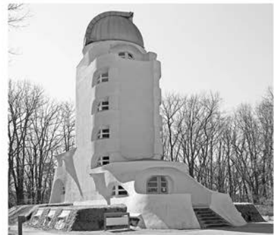
Observatorium im „Einstein-Turm“ in Potsdam
